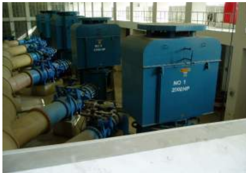
2,000HP 10P 6.6kV 60Hz TEAAC
